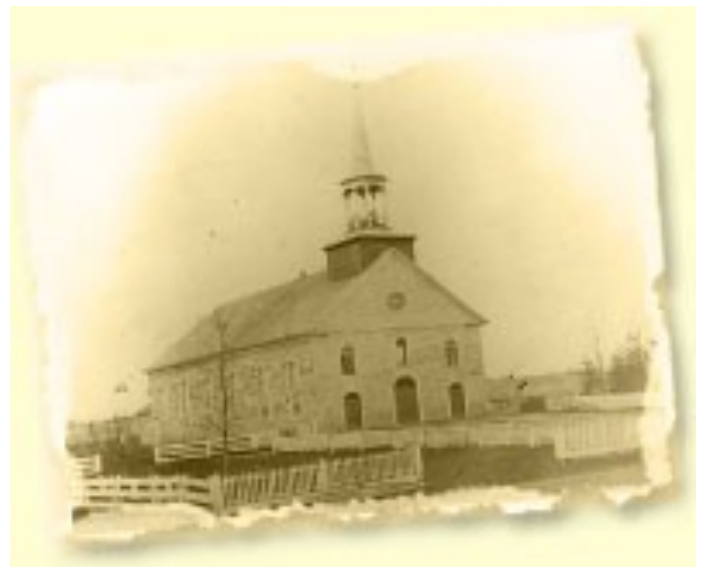
Ce n'est qu'à son arrivée définitive dans la paroisse, en 1854, que les travaux de construction du presbytère et de l'église sont entrepris. Toutefois, l'église n'est achevée qu'en 1861, puisque les plans initiaux ont dû être modifiés en cours de route, compte tenu de la faiblesse du sol. La première messe à y être chantée par Mgr Marquis s'est déroulée le 13 octobre 1861.
